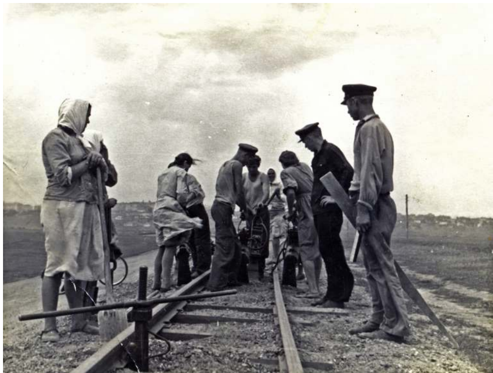
Начало строительства детской железной дороги, 1953 г.
