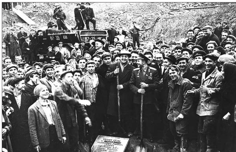
Ю. А. Гагарин на строительстве Красноярской ГЭС
