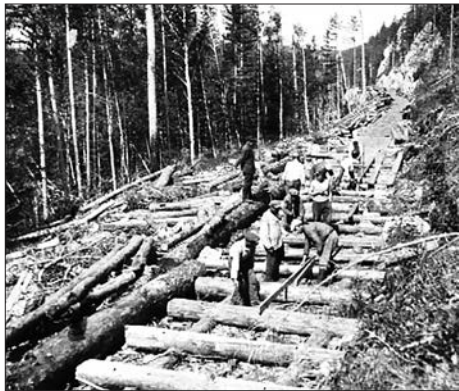
Укладка основания канала под сплотки
